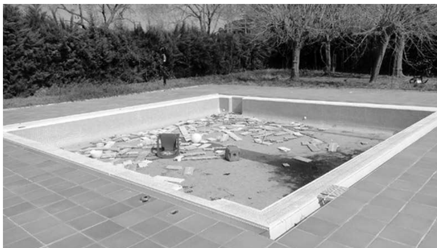
Estat actual de la piscina infantil.
